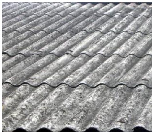
Rys. nr 1. Wyroby azbestowo – cementowe: po lewej płyty faliste, po prawej płyty płaskie, typ „Karo”
