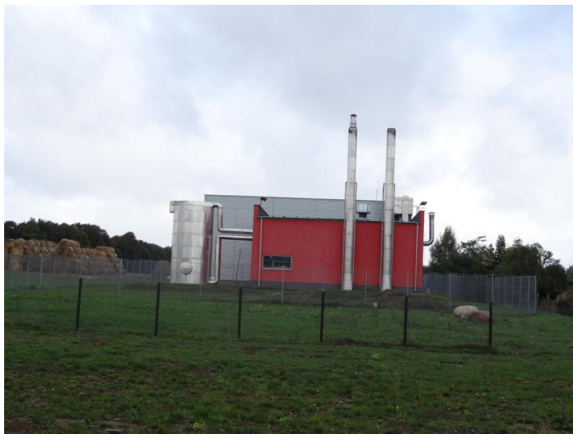
Fot. 5 Kotłownia na biomasę w Daszynie.
