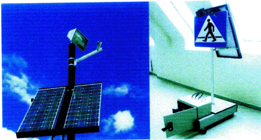
Rys 2 Systemy oświetleniowe małej mocy wykonane w oparciu o moduły słoneczne
